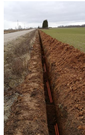
Attēls 2. Pamatrases inženiertīklu izvietojums tranšējā.
